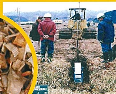
ポリエチレン製引込パイプ暗渠
